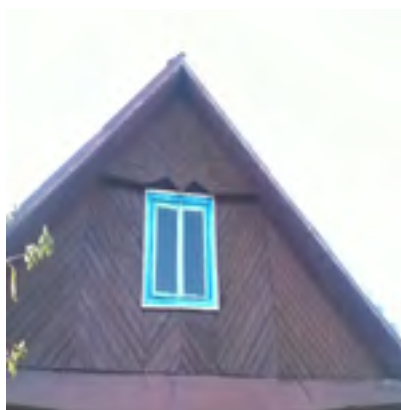
Рис. 11 Простой оконный наличник и накладка «Снежный язык»
